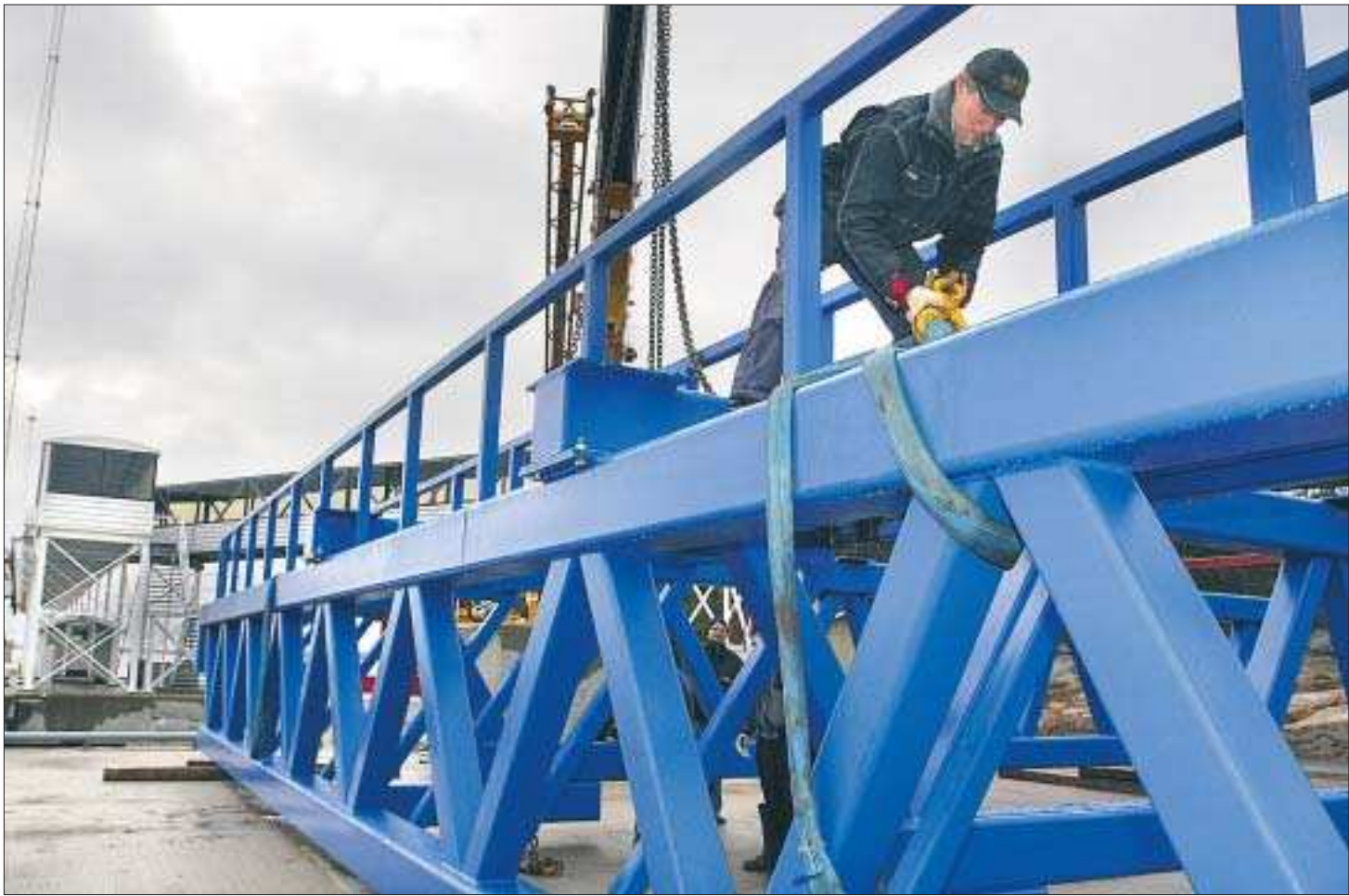
Arbete pågår. I sommar ska Långnäs hamn vara redo att ta emot Tallink Silja färjan Galaxy. Färjan är större än de som i dag anlöper hamnen, därför pågår som bäst ett intensivt ombyggnadsarbete. Willy Lindström förbereder lyftet av ett nytt landgångsfundament.
