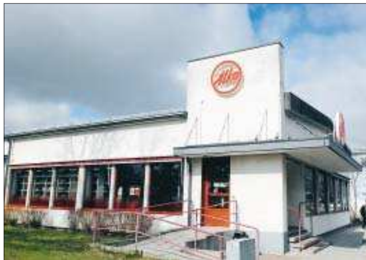
Ny skylt. Alkohuset har fått en ny skylt, fönstren har färgats röda i nedre kanten och ingången har byggts om med dörrar som öppnas automatiskt.
