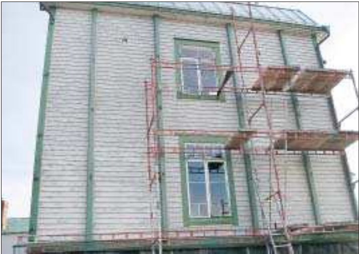
Kännemärke. Den kännsbaka lotsstugan på Kobba klintar får just nu ny färg på norra och östra sidan. Bygganden är 14 meter hög som högst. Foto: RENE KARLSSON
