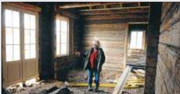
Halvfärdigt. Så här såg det ut innan man hade fått upp väggarna. Freya Darby visar var södra dörren ska vara. Arkivfoto: JONAS EDSVIK
