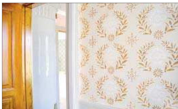
Målat för hand. Köksväggarna är schablonmålade direkt på väggen
