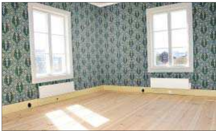
Västra salen. Här har man hittat tapeter som påminner om de gamla tapeterna i västra salen. Det var det rum där elden började.
