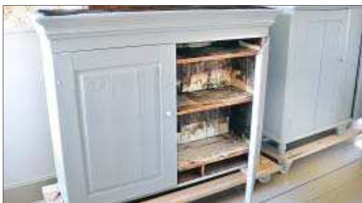
Köksskåp. Köksskåpet vittnar om eldens härjningar. Ovansidan är förkolnad och insidan är svedd.
