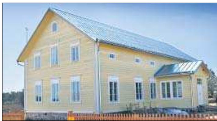
Färdigt. Nu står Skeppargården Pellas nästan färdig igen. Här ser vi det nordöstra hörnet.
