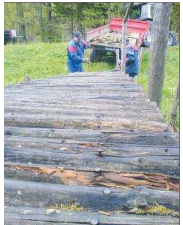
Renoveringsobjekt. Bron var i så pass dåligt skick att den måste renoveras. Foto: INGEMAR JOHANSSON
