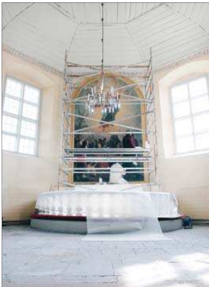
Snart färdigt. Nu börjar den sista delen av arbetet ned restaureringen av Lemlands kyrka, uppsatsningen av altartavlan, vara avslutad.
