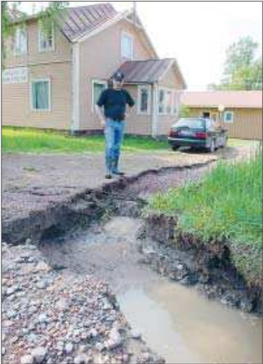
2007. Vid skyfallet för ett år sedan grävdes infarten av akut för att öppna för regnvattnet vid sidan av tomten.
