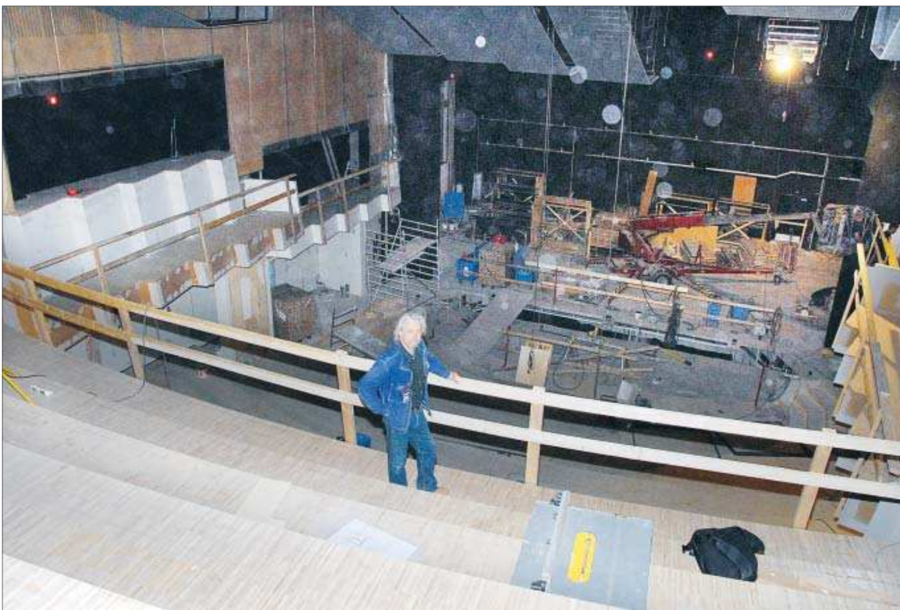
Balkong. Från balkongen syns den snart färdiga scenen. Arbetsledare Patrik Sundblom lutar sig mot det provisoriska räcket som ska bytas ut mot ett av glas.
