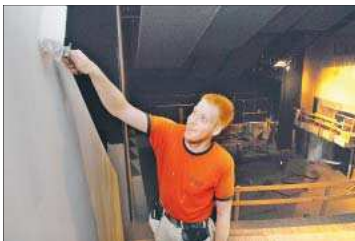
Grundar. Daniel Nordlund grundmålar väggarna uppe på balkongen.
