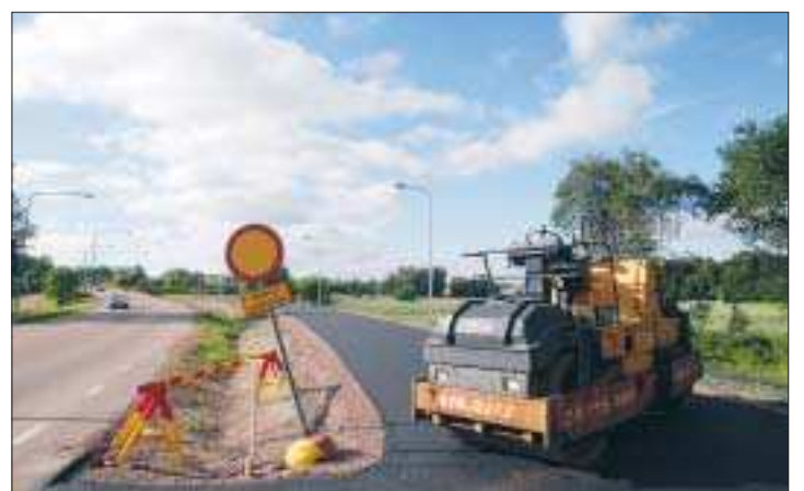
Smitfil asfalterad. Smitfilen vid Östra utfarten är nu belagd. Av arbetet återstår skyltning och målning, sedan kan vägen tas i bruk, informerar trafikingenjör Stig Janson.
