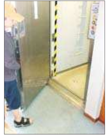
Hissen på Alfågeln har en låg tröskel för att underlätta för rörelsehindrade. Men man behöver hjälp att hålla upp dörren. Här hjälper Josef Smeds till.
