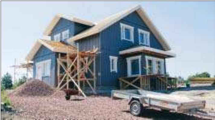
Snart färdigt. Det nya huset, ett så kallat Vaajatalo som inte är så vanligt på Åland men vanligt i riket, är byggt för att så bra som möjligt passa in i miljön omkring. Den gråa färgen valde de för att huset skulle smälta in mot klipporna bakom.
