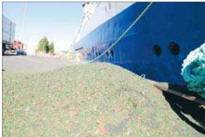
Färgflagor flyger. Patrik Landell, som äger Patriks Måleri menar att de tar vara på det allra mesta av färgflagorna. De samlas ihop och förs till en depå för problemavfall. Lite flyger dock bort i vinden. Riktigt all blästringssand går inte heller att samla ihop, därför sopas den av däck. – Jag skulle gärna se mer detaljerade regler från landskapets håll kring hur sådant här ska skötas, säger Landell till Nya Åland. Foto: FREDRIK TÖRNROOS
