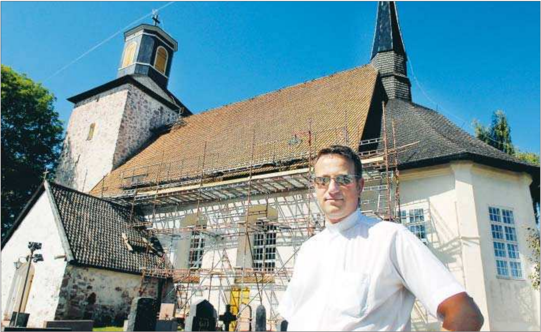
På slutrakan. På utsidan ska taket ännu tjäras och beskäras på södra sidan, annars är den utvändiga delen av restaureringen färdig för denna gång, berättar kyrkoherde Benny Andersson.
