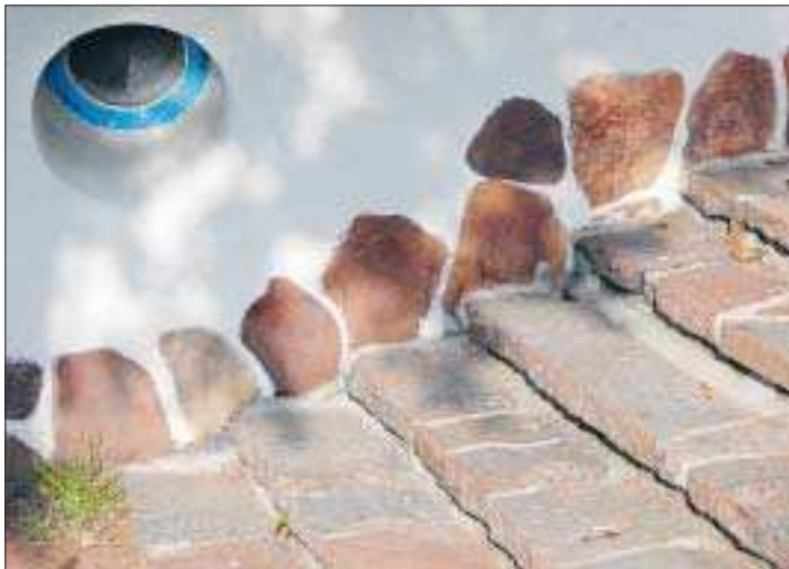
Ventil. Ett runt fönster i källarplanet som för tankarna till fartygsventiler.
