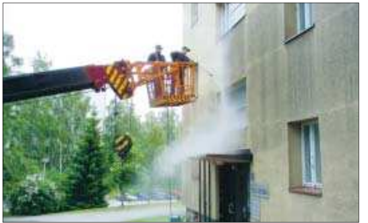
På puts. Medlet kan användas på vilka material som helst, som här på betong. Företaget har hittills behandlat cirka hundra egnahemshus och daghem på Åland och olika fastigheter ägda av Ålandsbanken. Medlet har också använts för att flamskydda Pellas i Lemland.
