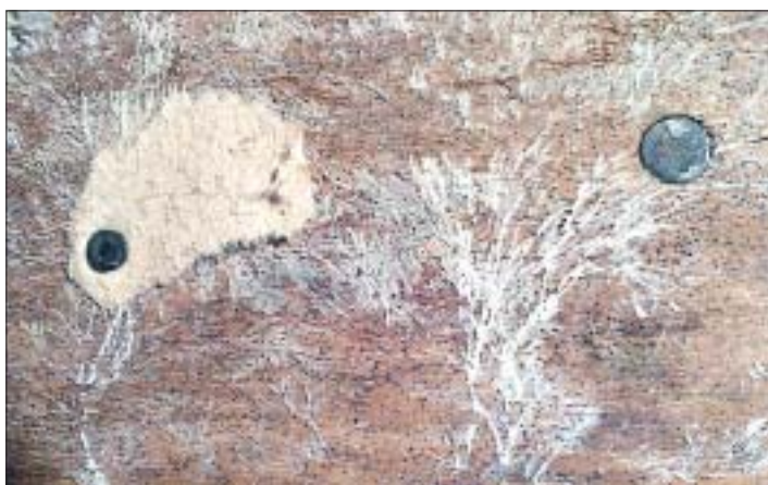
Angrepp. Så här såg en del av de brädor ut som togs bort inne i huset. Foto: PRIVAT
