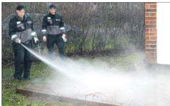
Sanerare. Företaget WSJ Sanitations killar i full färd med att mögelsanera huset. Medlet som används är en förening av olika borsalter utan tillsats av giftiga ämnen. Foto: PRIVAT
