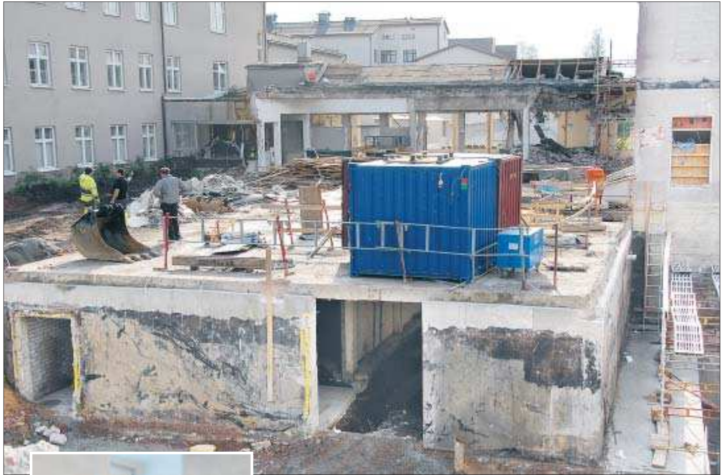
Taket rasade in. Under ombyggnaden av sjukhuset i Mariehamn gick borren rakt igenom taket till det sterila varulagret. Genom hålet rasade vatten och damm, och lagret kunde till följd inte längre klassas som sterilt.
