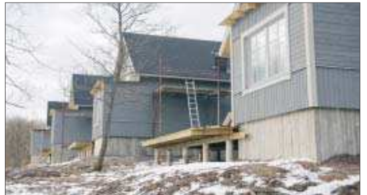
Under byggnad. Så här såg det ut på Brändö Baggholma i mars i år när de fyra första radhusen på området byggdes.
