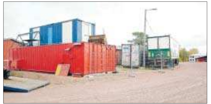
Städat. Subsea Åland har städat upp på sitt område i Korrvik. Bygglov för sina containrar har man ännu inte sökt. Foto: JONAS EDSVIK
