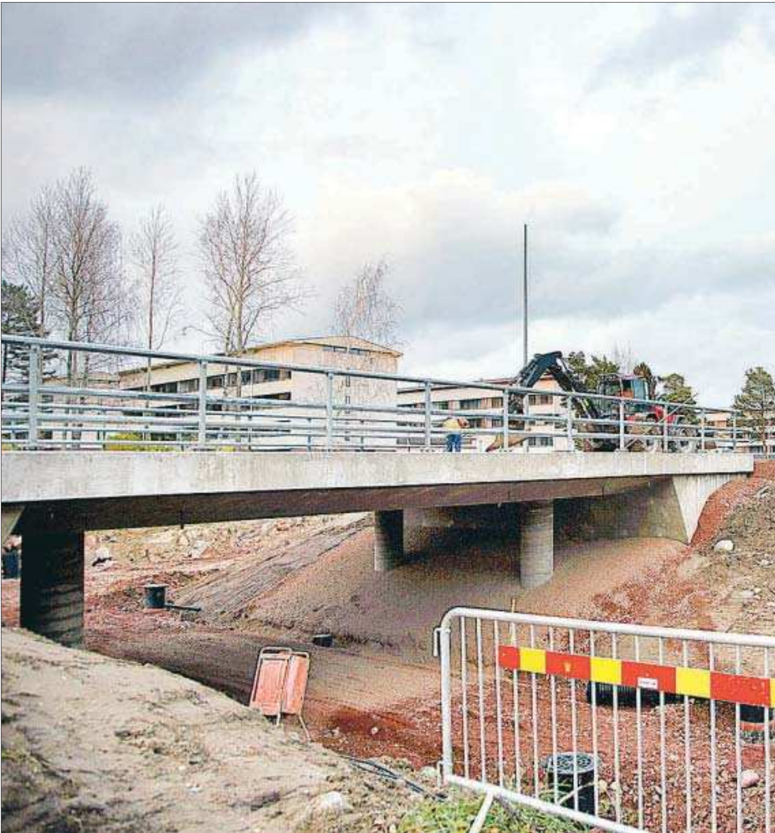
Senaste olyckan. Bakdelen på en grävmaskin körde rakt in i vindrutan på en personbil vid vägbygget vid Nabben i början av uppfyllde alla säkerhetskraven. Bilisten hävdar det motsatta, och ärendet utreds nu av polisen.
