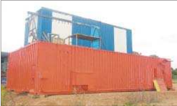
Container i Korrvik. Höglund har fått mycket kritik för sitt lager i Korrvik i Mariehamn, men ska nu söka bygglov för sina containers.
