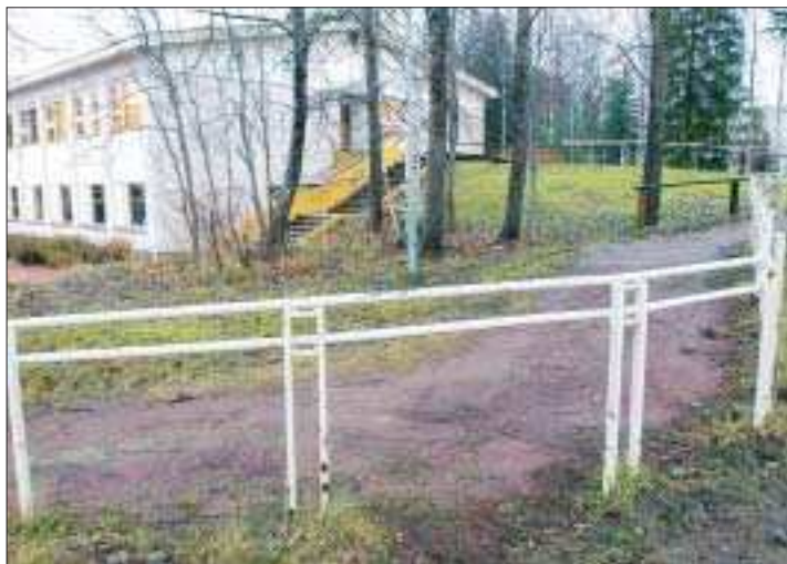
Över eller under. Det här räcket längs gången runt skolans södra sida hoppar eleverna över eller kryper under på vägen till och från bussen.
