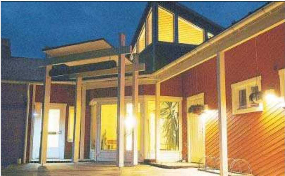
Servicehus. Annagården ska saneras och renoveras.
