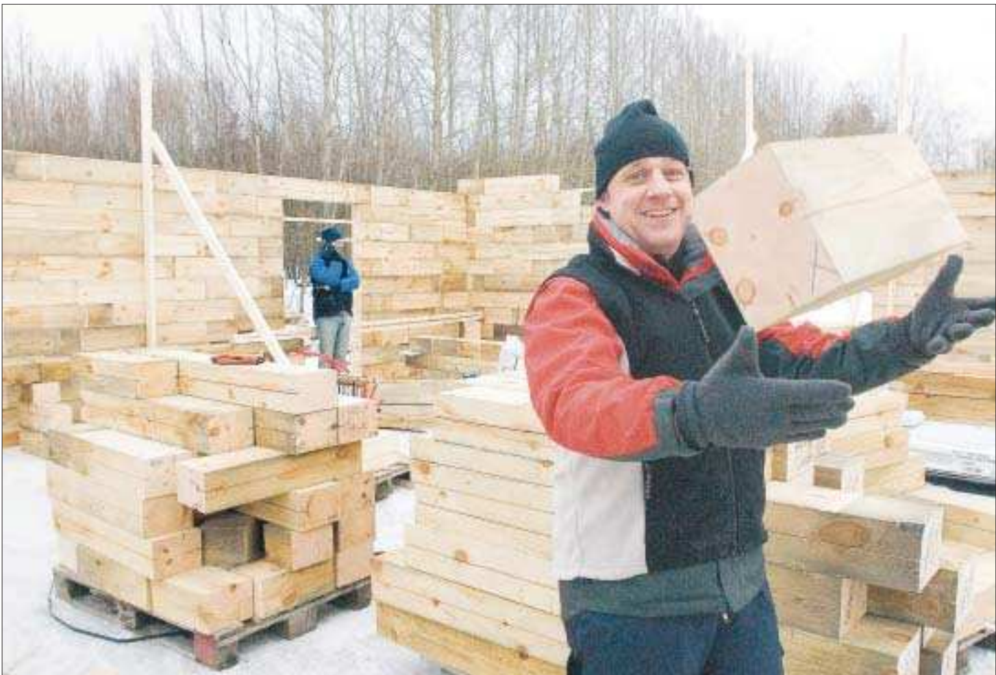
Första i hela landet. Thomas Fagerstedt är tillsammans med Lillemor Svens de första i Finland som bygger ett GDS-hus. Huset byggs av träblock som ska vara lätta att hantera för en person, vilket Thomas demonstrerar på bilden.
