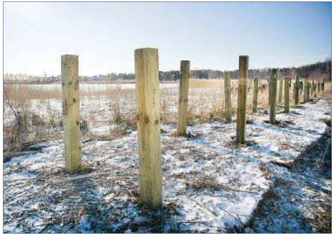
Bottenlöst. De fyra meter långa pålarna går lätt ner i marken.
