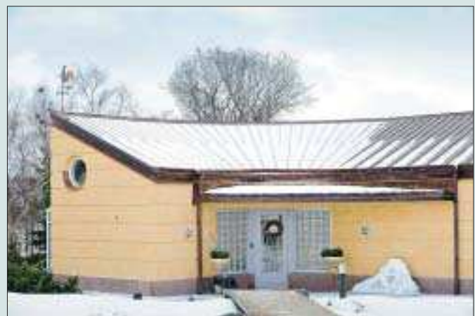
Orangeriet från norr. Huvudentrén är i stendelen som vätter mot norr. För att komma till dörren får man gå längs en bro över en damm.
