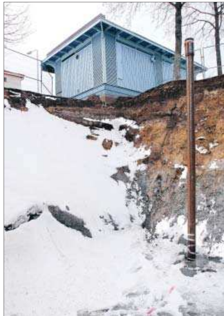
Många pålar. Flera hundra spetsiga pålar i stål slås ner till berggrunden för att stabilisera bygget.
