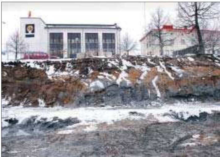
Under jorden. Fyra-fem meter under tidigare markyta har man grävt sig ner inför byggandet av garaget som ger cirka 130 nya parkeringsplatser i centrum.
