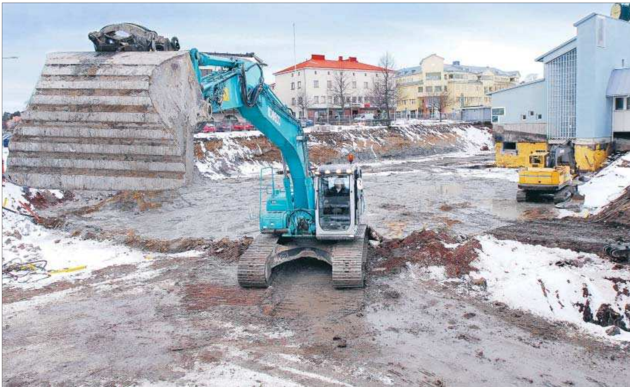
Gräver sig ner. Schaktningsarbetet är full gång och pålningsarbetet har just påbörjats i gropen där Miramargaraget ska byggas. Om ett par veckor räknar man med att gjutningsarbetet kan inledas.
