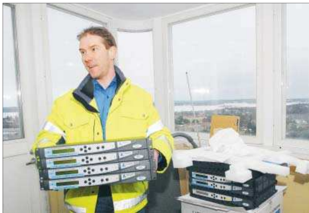
Ut med det gamla. Daniel Nordback från MCA visar upp delar av det man kastat ut ur kontrollrummet för att få plats med det nya.
