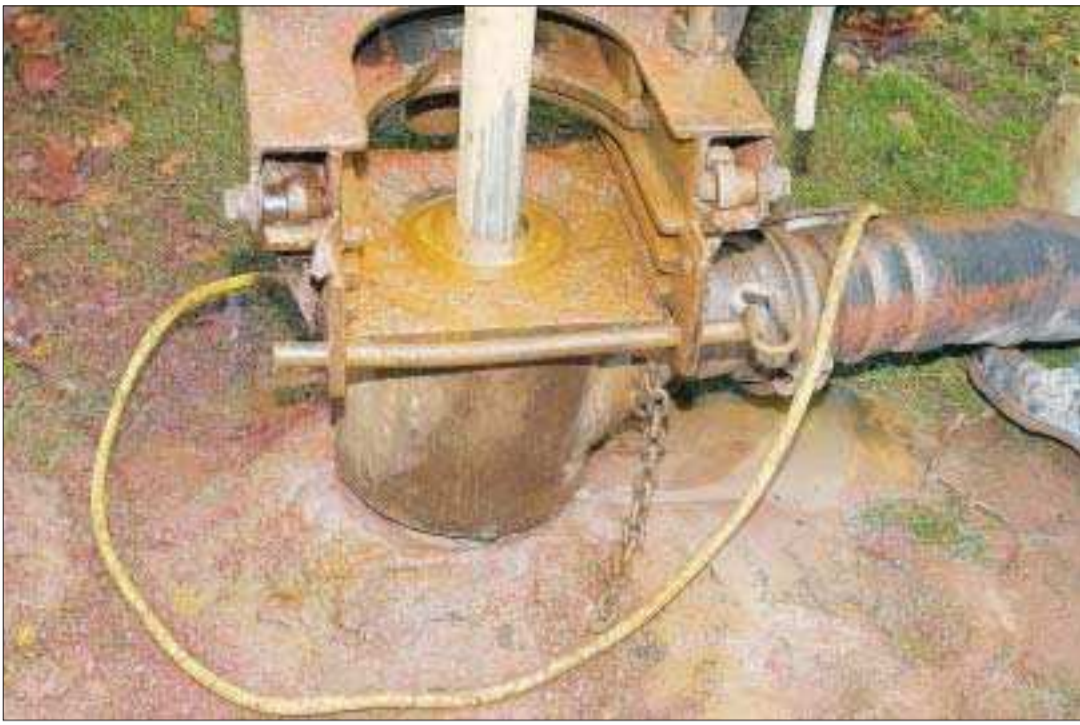
Omdebatterat ämne. Frågan om borrning av energibrunnar för bergsvärme lyftes i lagtinget i går av Harry Jansson (ÅF). Arkivfoto: ERKKI SANTAMALA
