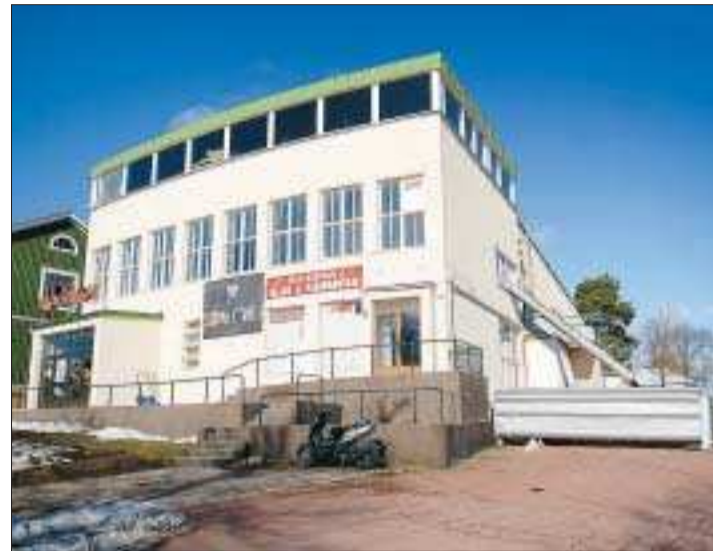
På gång. Besluten inför renoveringen av Bio Savoy tar nu steg framåt. Vissa förberedande arbeten har redan kunnat inledas inne i fastigheten.
