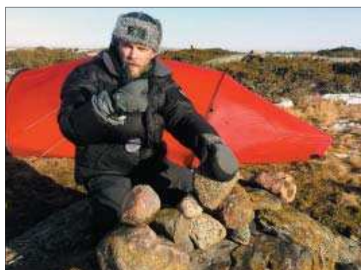
Vindsydd. Martin bygger en stenmur.
