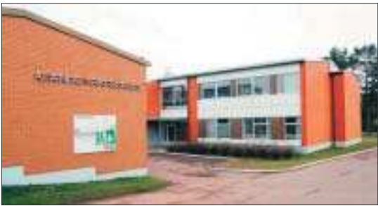
Härd kritisk. En anställd vid Ålands yrkesskola är sjukskrivna efter att ha jobbat i mögeltrabbade utrymmen. ”Den här fuktskadan har häntats med en sådan oaktighet och nonchalans av de yttre ansvariga för skolan och för hantieringen att det i sig är sådant att uttrycka”, skriver hennes fackliga organisation FOA-Å i ett brev till landskapsregeringen. Foto: FREDRIK TÖRNROOS
