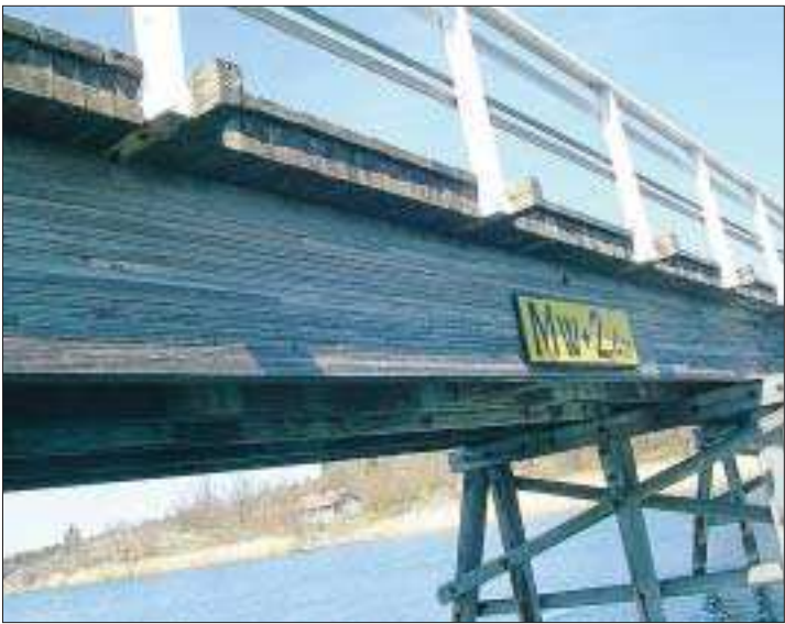
Röta. Nötöbron i Föglö lider av rötskada bland annat på snedpälarna som ska hindra brokonstruktionen från att svaja. Foto: PRIVAT
