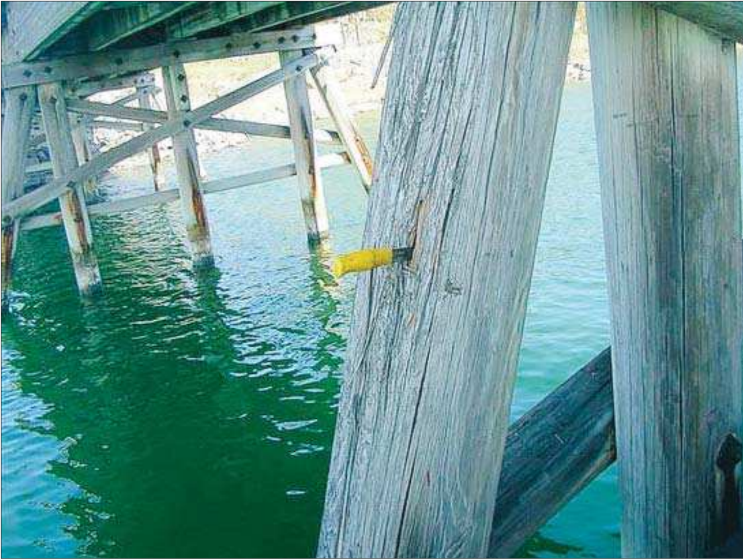
Röta. Nötöbron i Föglö lider av rötskada bland annat på snedpälarna som ska hindra brokonstruktionen från att svaja. Foto: PRIVAT
