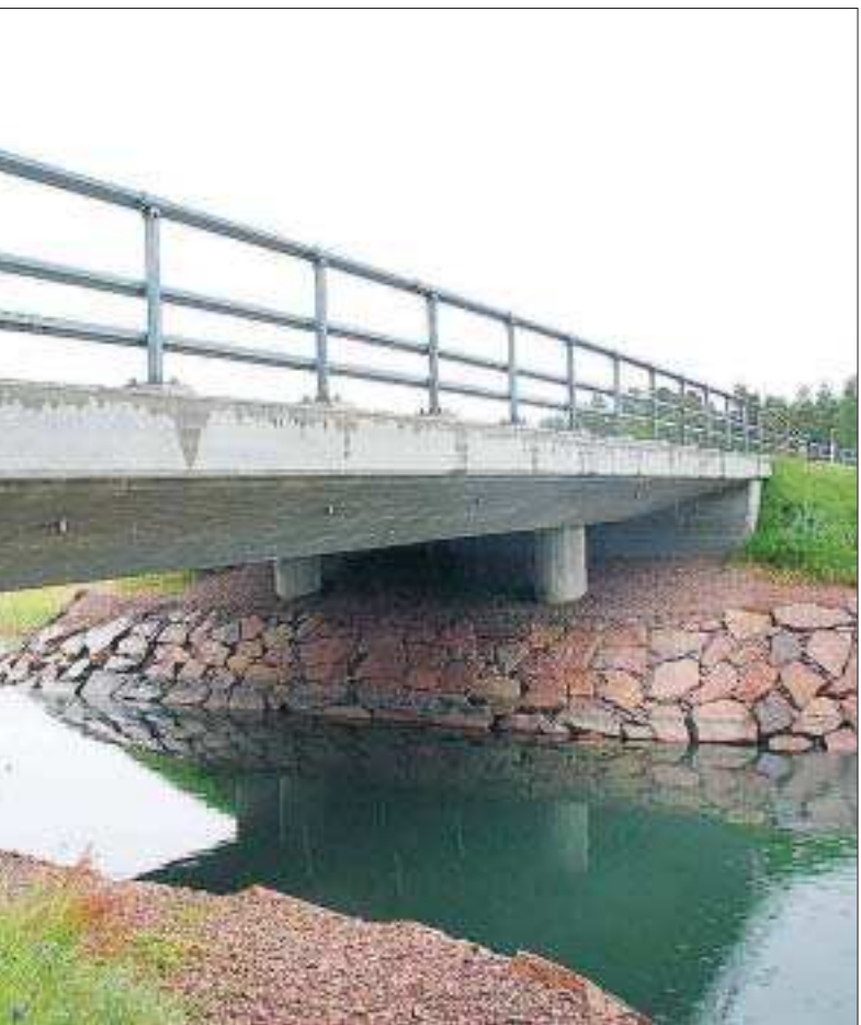
Lumparsunds bro i Lemland är en plattbro i stål och betong, Åland. Den här bron hör till de nyaste, den är byggd år 2001 bro.
