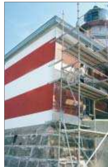
Kontrast. Här syns skillnaden mellan den nymålade väggen och den omålade.
