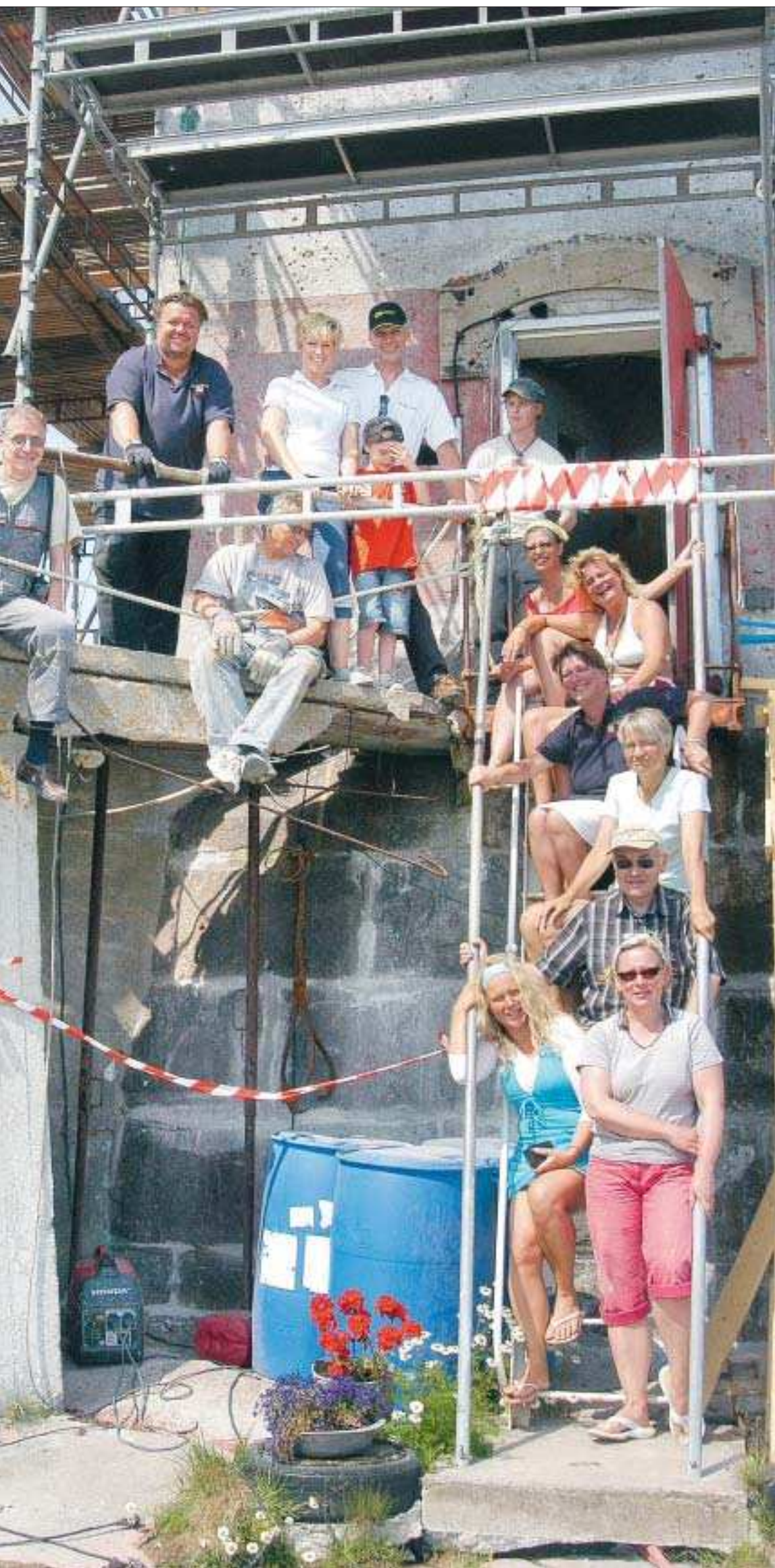
besöker Märket finns 11 personer som jobbar med renoveringsarbetet. Stående från vänster: Ari Valio, Mikael (de kör taxibåten) och Daniel Nordvik från Görans Fasad & Bygg. Sittande på avsatsen från vänster j Karrento. På trappan sitter uppförifrån Tarja Kedrin, Anna Mustakallio, Nina Martikainen, Katrin och Henryk en och Kristiina Ahlstedt. På bilden fattas målaren Mikael Helén.
