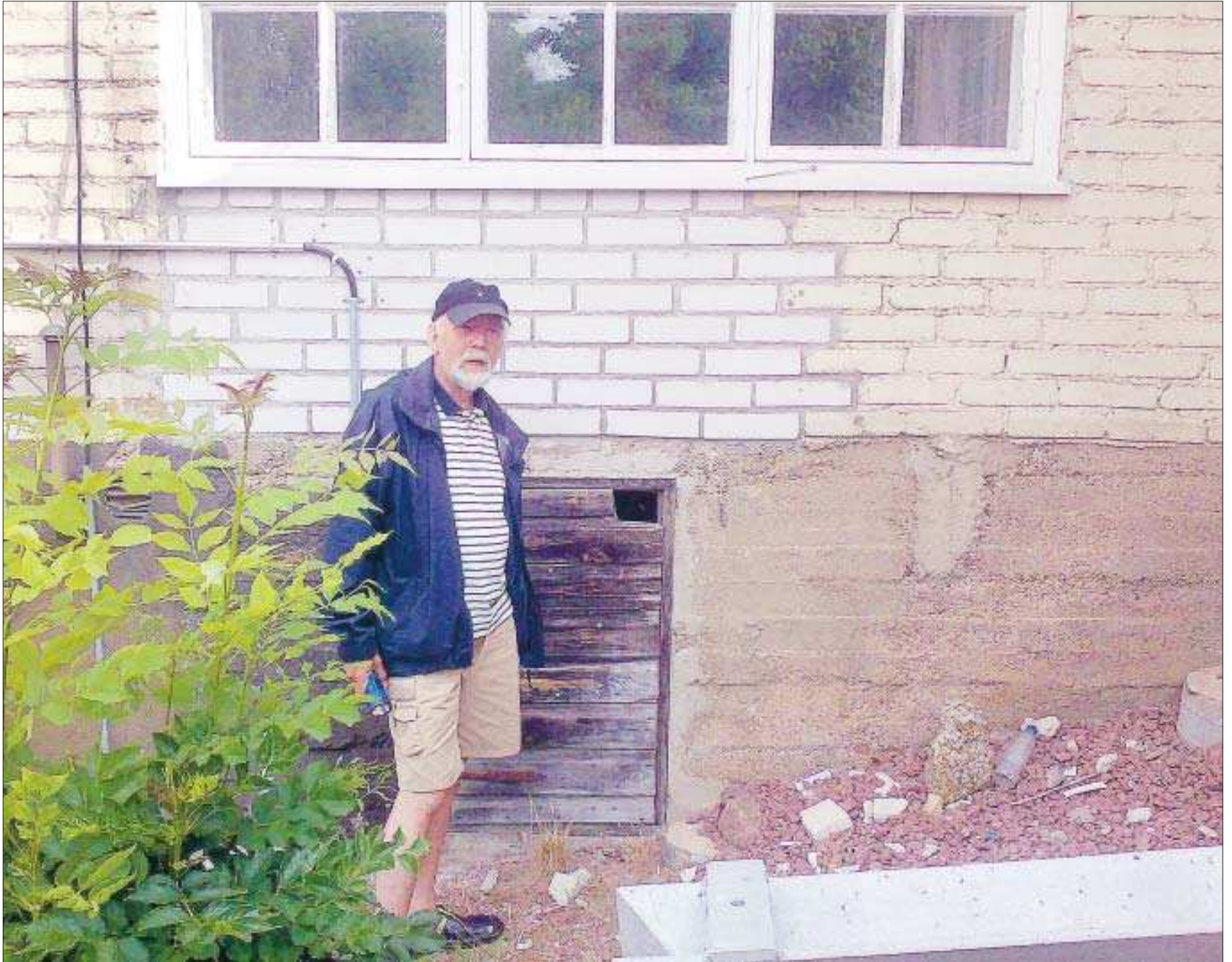
Detektivarbete. Här in i under gamla snickerihuset kröp Folke Wikström och Jerker Örjans och hittade Klinttorpets grund fullt synlig. Foto: KATARINA GÄDDNÄS
