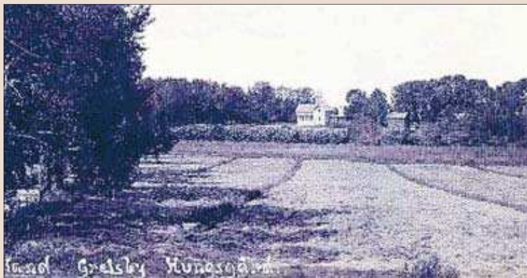
Utsikt 1930. Mangårdsbyggnadens östra gavel syns till höger i bild. Bostadshuset i mitten tillhörde familjen som arrenderade gården och huset flyttades när arrendetiden gick ut.
