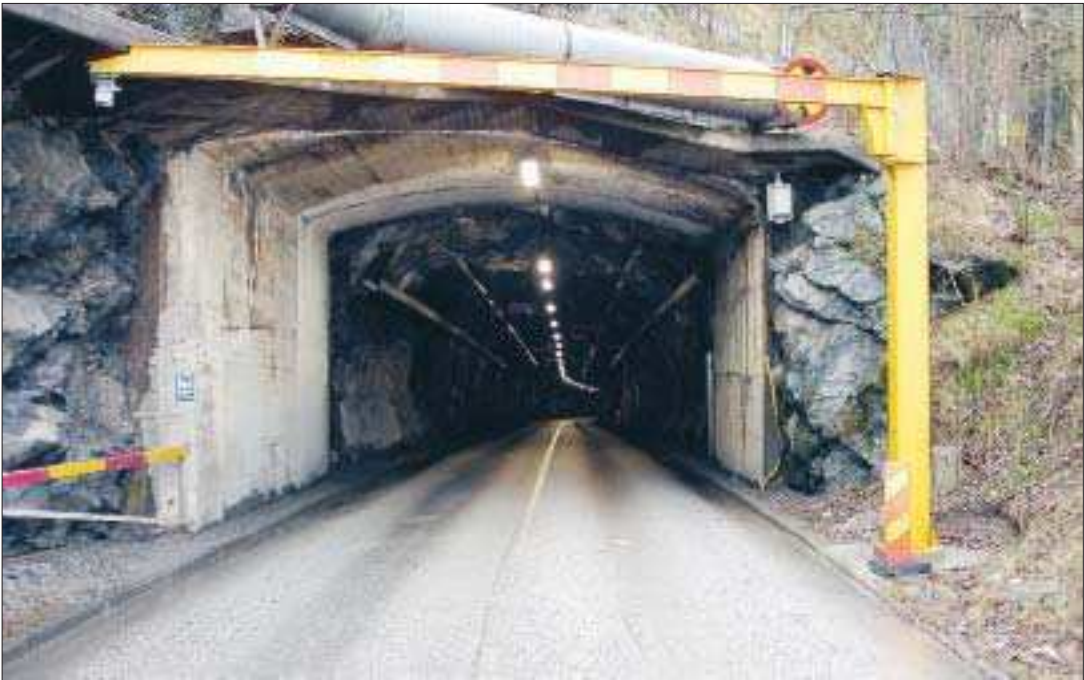
Merkostnader. En tunnel medför också kostnader. Kan man verkligen vara säker på att tunnelalternativet är det billigaste sättet att ordna Föglötrafiken, undrar insändarskribenten? Bilden är från Muskötunneln utanför Stockholm.
