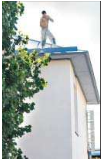
Farligt. Att arbeta på tak medför en hel del risker och det finns en förordning som säger att säkerhetsutrustning ska användas. Här en arbetare utan utrustning på Postens tak i Mariehamn. Foto: STEFAN ÖHBERG
