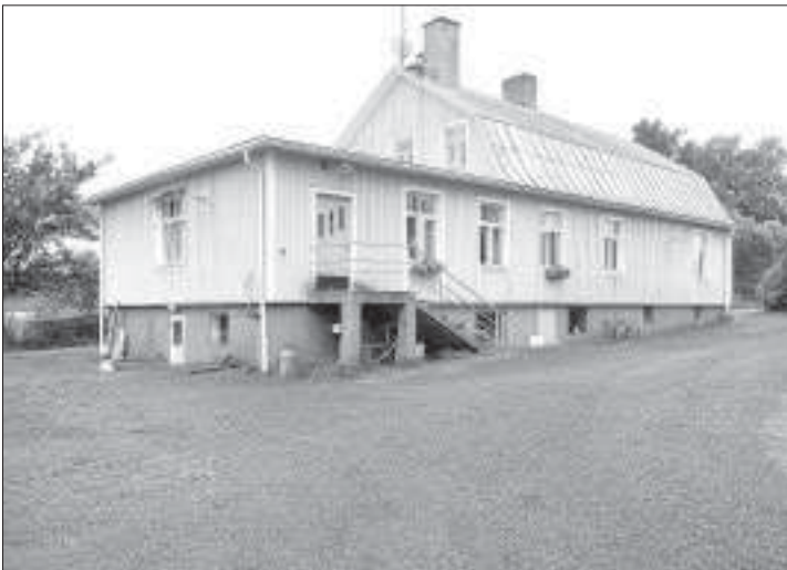
Otidsenligt. Stiftelsen Hemmets gula hus har stått på samma plats sedan början av 1900-talet. Tillbyggnaden kom till på 1960-talet. Nybygge planeras nu bakom huset i skogskanten.
