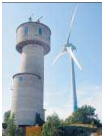
Stilla. Under de kommande dagarna kommer Båtskärs vindkraftverk att stå stilla.
