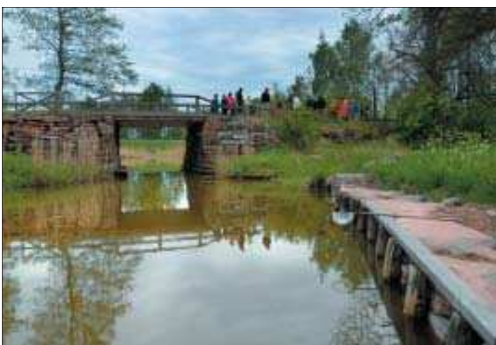
Bjärströms bro. Etapp 8 är fin vid gamla bron.
