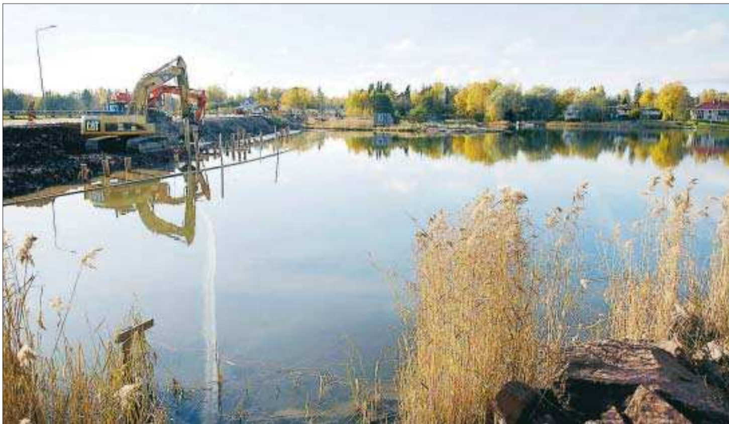
Stopp. Ålands schakts grävmaskin får inte börja gräva upp muddermassorna vid Svibybron förrän man har meddelat landskapet vart de giftiga och förorenade massorna ska föras. Foto: JONAS EDSVIK
