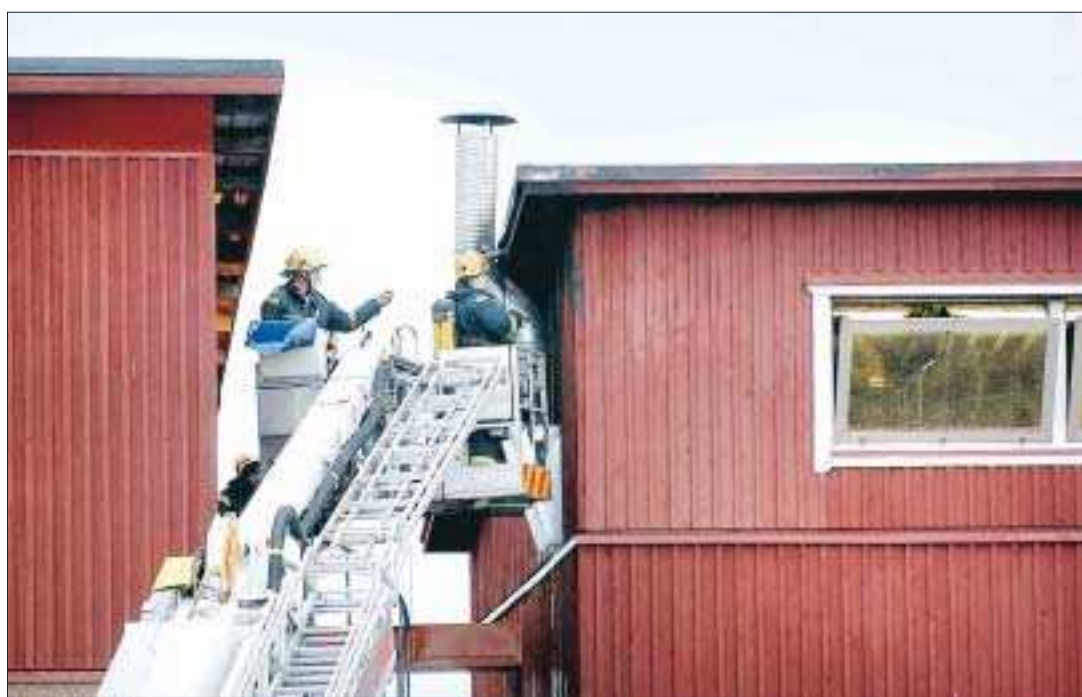
Nära ögat. Stegbilen behövdes för att brandmännen skulle komma åt taket på fjärrvärmecentralens pannrum. Foto: JONAS EDSVIK
