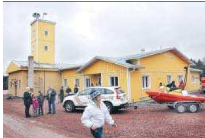
Dubbelt så stort. De gamla utrymmena på 200 kvadratmeter har renoverats och byggts till. I dag har ÖSFBK hela 400 kvadratmeter lokal.
