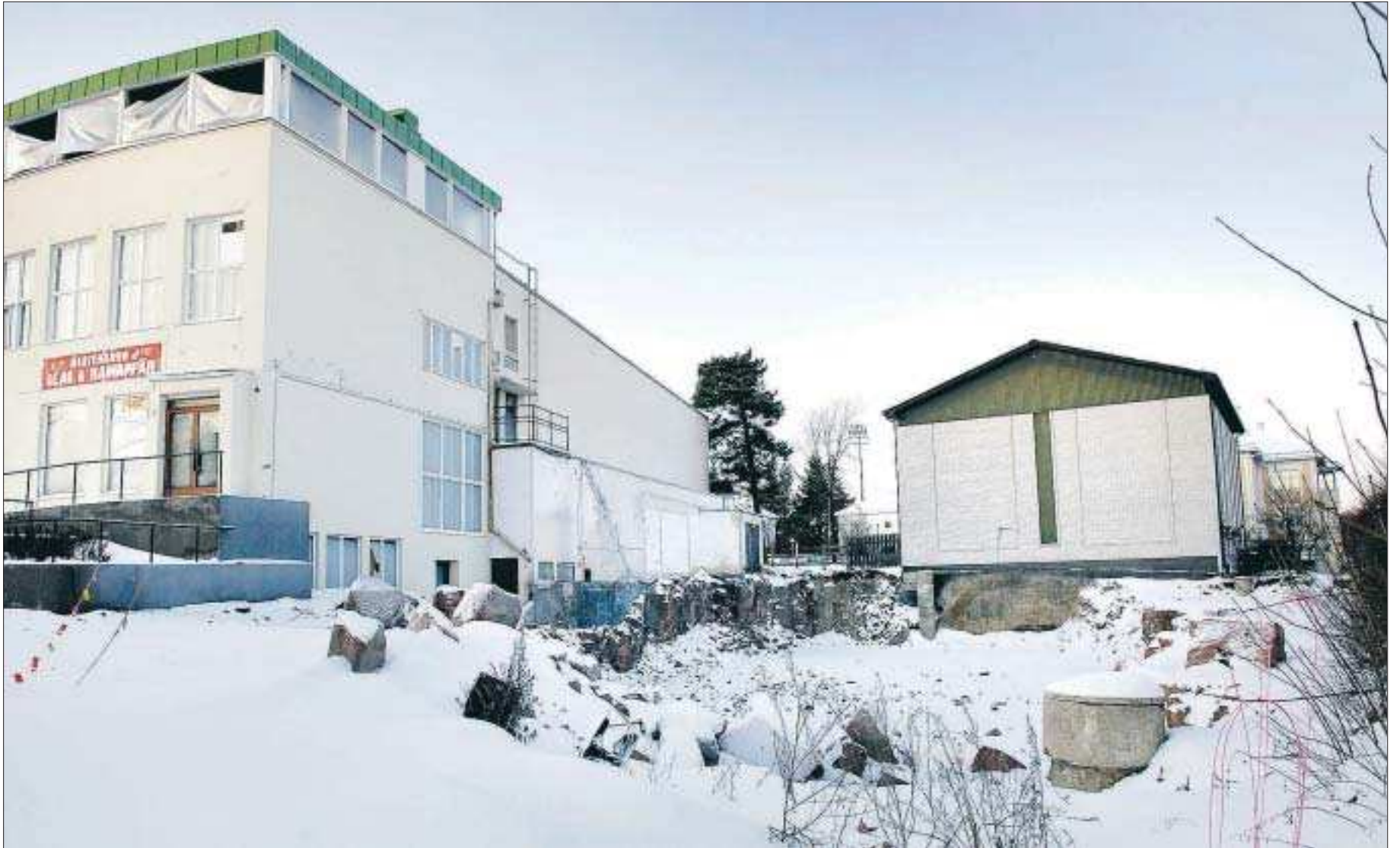
Grop i väntan. ”Britt Lundberg var jävig när det togs beslut om Savoy i stadsfullmäktige”. Det anser ägarna till grannfastigheten och har överklagat till domstol. I väntan på dom står arbetet stilla på byggplatsen vid Ålandsvägen. Foto: JONAS EDSVIK
