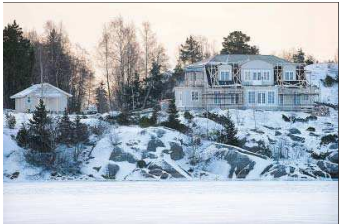
Jättehus. Det är nästan ett slott som mariehamnaren Jacob Halling låter bygga på Kedholm som hör till Järsö by. Avståndet till vattnet är 35 meter. Foto: ERKKI SANTAMALA
