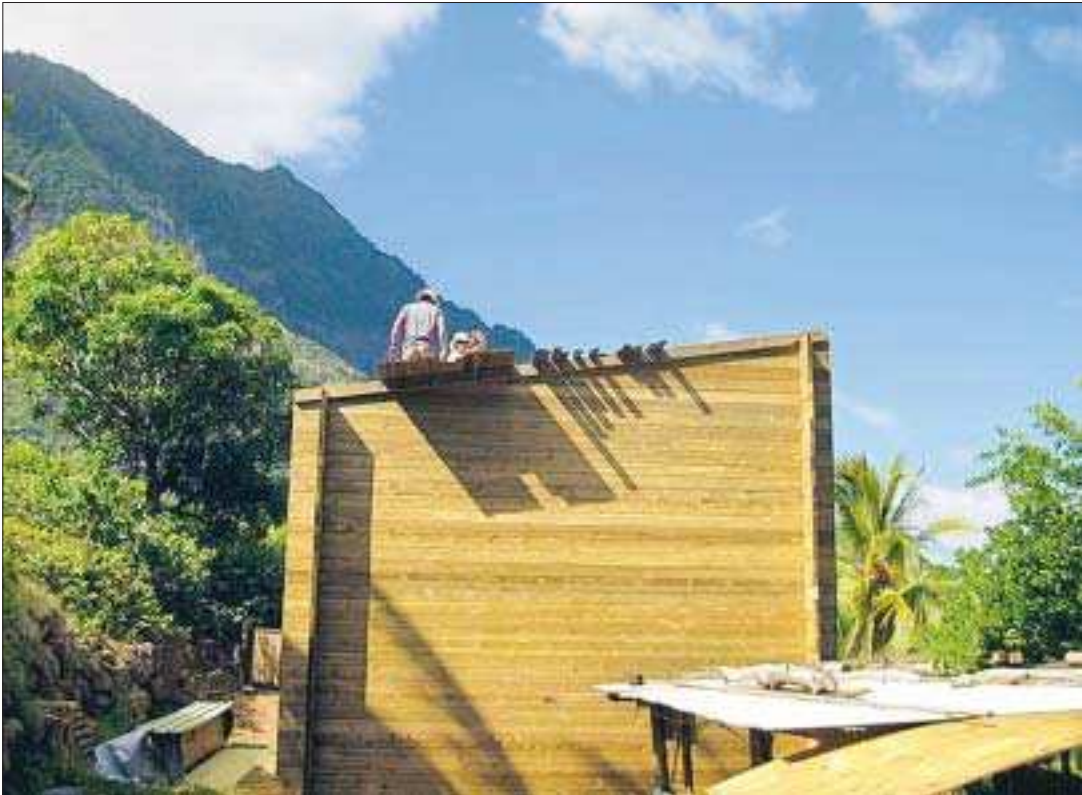
Hisnande utsikt. Utsikten från byggplatsen kan man inte klaga på. Grönskan och bergstopparna som sträckte sig mot skyn var en stark upplevelse för Folke Engblom.
