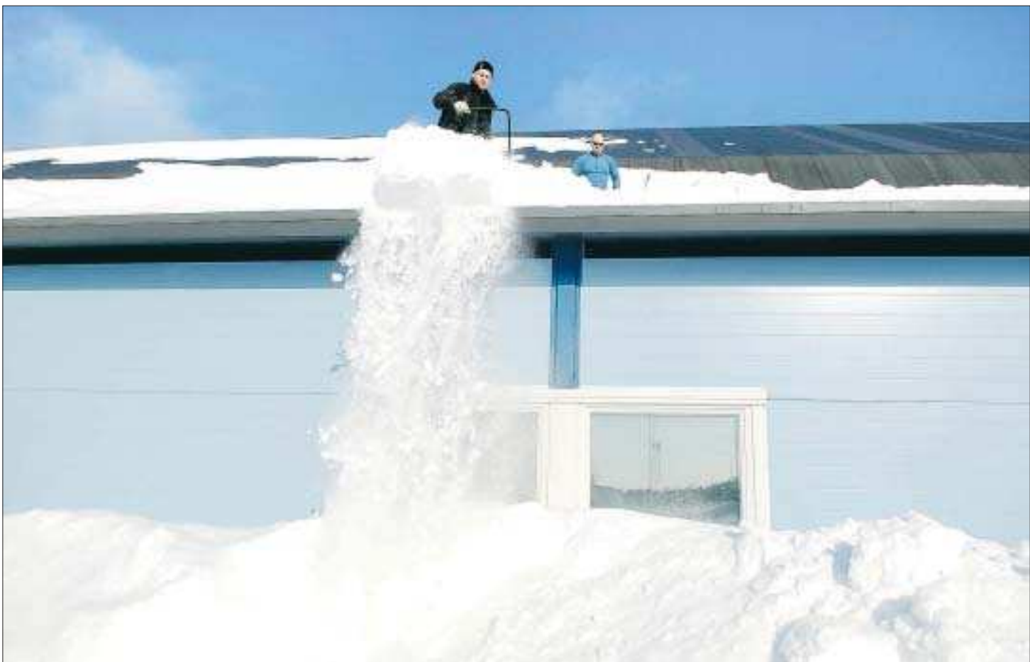
Vinterjobb. Här tas snön bort från taket på Eckeröhallen, för att förhindra eventuella rasolyckor och att tyngden på taket ska bli för stort. Foto: JONAS EDSVIK
