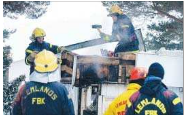
På väg in. Brandkåren fick ta loss bräderna med kofot och slägga för att kunna se branden i mellantaket.
