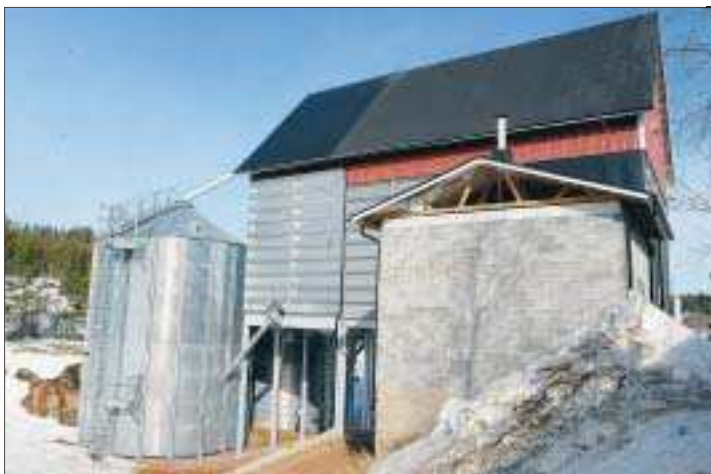
Stort projekt. Torken har byggts till, åtta spannmålssilor har uppförts och en biobränslepanna har installerats i pannrummet.
