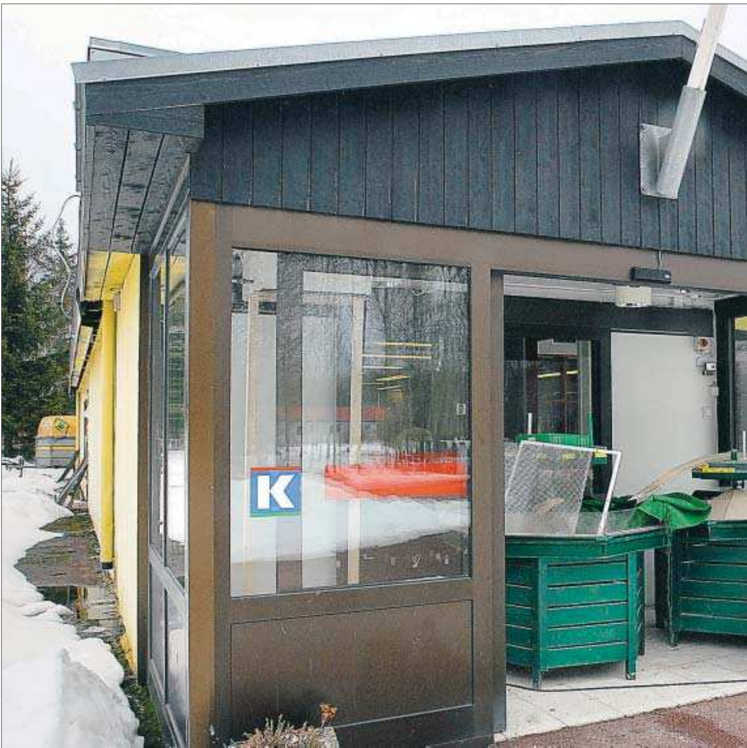
Ombyggnad pågår. I slutet av maj öppnas en ny livsmedelsbutik i Matnischens gamla lokaler. Till höger om ingången planeras
