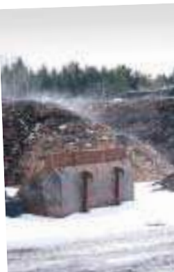
Högar. På som alla har ventilationsrör.
