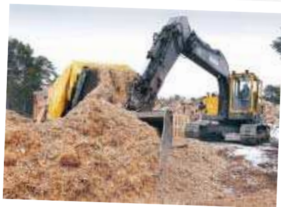
Grävmaskin. Den stora grävmaskinen är ett av arbetsredskapen som Bengt Karlsson har till sitt förö- gande då han jobbar på kompostanläggningen.
