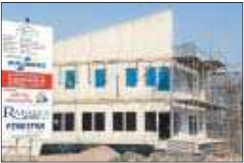
Det nya privata vårdhuset byggs som bäst i Möckelö. Foto: ERKKI SANTAMALA
